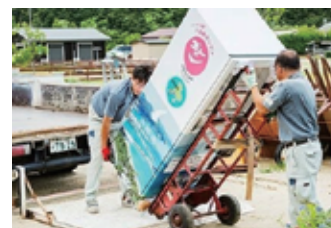
④納品・設置
